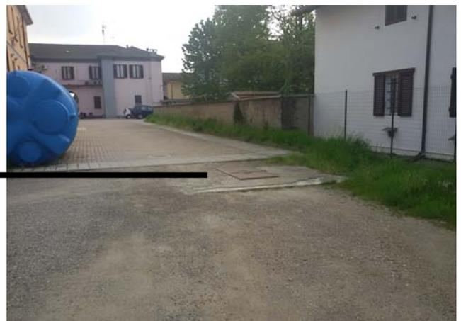
La situazione generale è ben visibile nella fotografia sottostante. Allo stato attuale non è presente alcuna recinzione particolare che delimiti l'area di rispetto assoluta pari a 10,00 metri di raggio dalla testa del pozzo. La stessa testa del pozzo risulta essere appena al di sotto della suddetta botola ed è collegata alla centrale idrica tramite una tubazione di mandata interrata.
