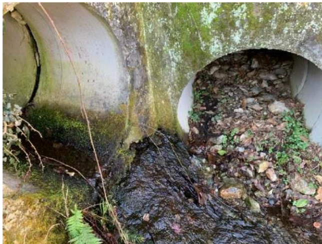
Foto nr.2 Tombotto intasato e acqua infiltrata sotto la tubazione
