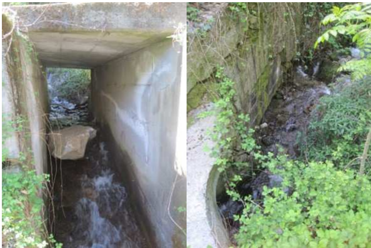
All'uscita della vasca, si dovranno posizionare putrelle d'acciaio, che fungano da pettine di trattenuta del materiale detritico, per evitare che si possa depositare in corrispondenza dell'attraversamento stradale, ostruendolo.
