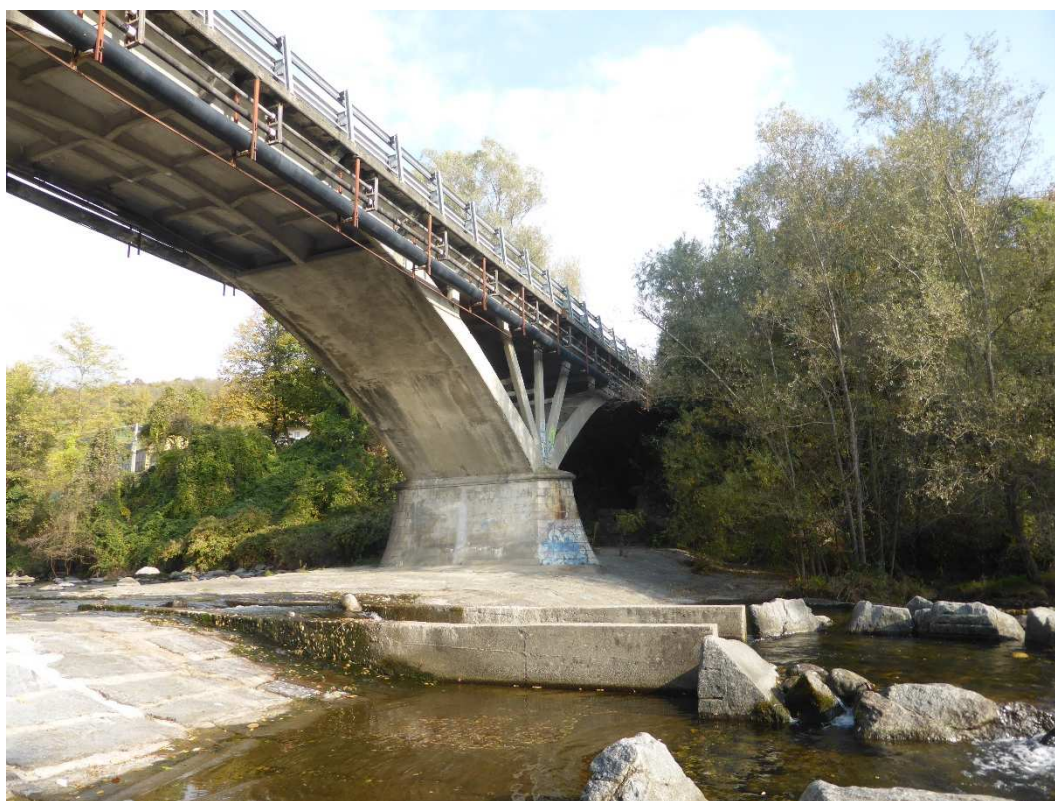
Figura 15. Foto del ponte di via San Giovanni Bosco dalla sponda destra del Torrente e delle tubazioni ancorate sotto
