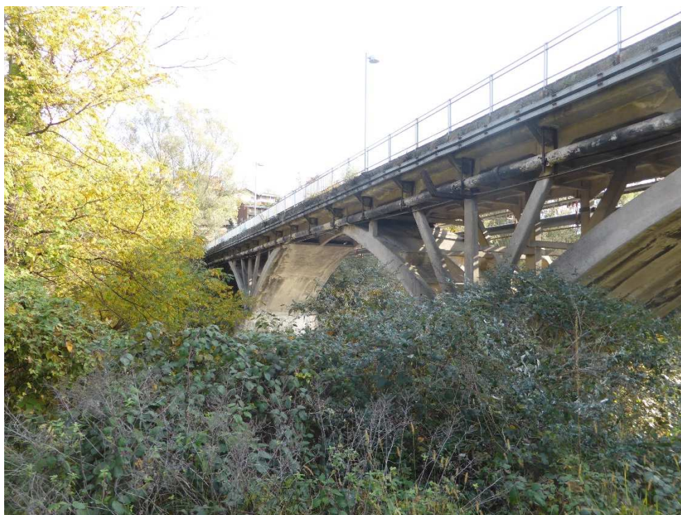
Figura 13 . Foto del ponte di via San Giovanni Bosco dalla sponda destra del Torrente e delle tubazioni ancorate sotto
