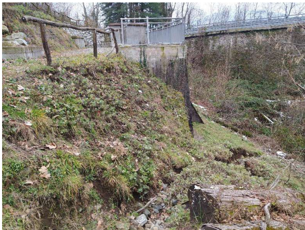
Fig. 6.1 – Fenomeni di erosione lineare nell’area del serbatoio
