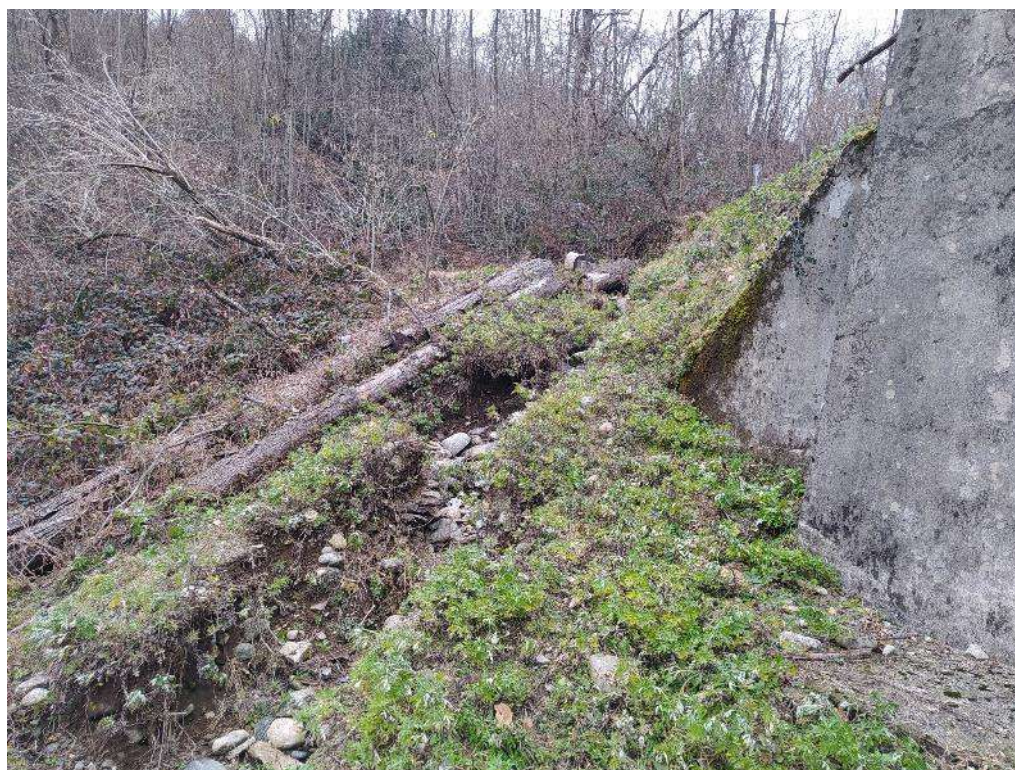
Fig. 6.2 – Fenomeni di erosione lineare nell’area del serbatoio
