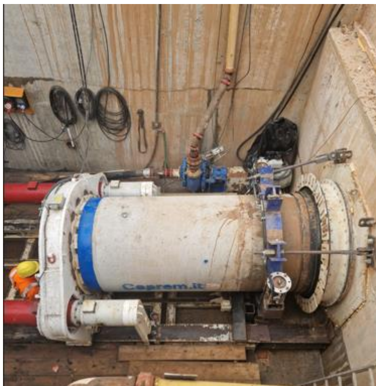
Figura 19 esempio di spinta a scudo chiuso con freno idraulico
