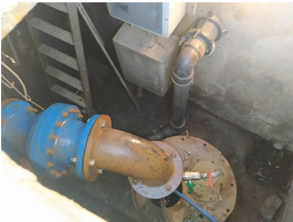
Figura 9 - pozzo Roddo 1 esistente – particolare testa pozzo
