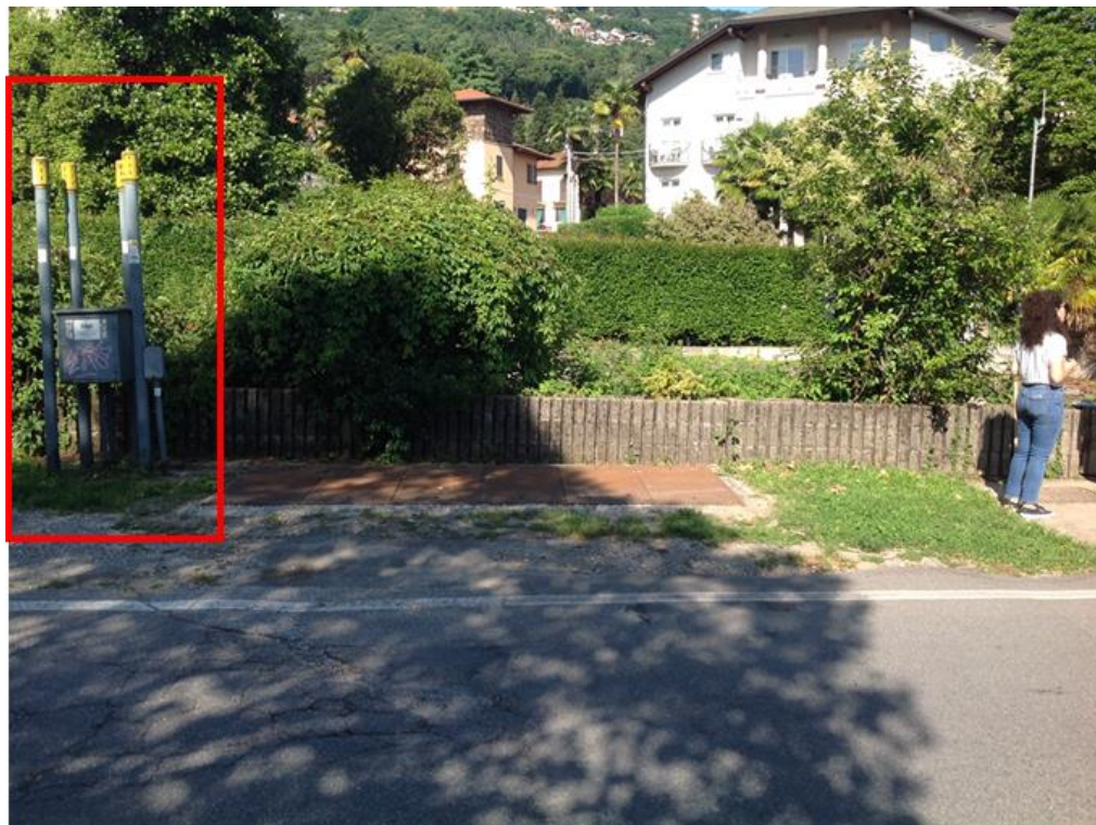
Figura 2 – Impianto di distribuzione gas metano in prossimità dell'area di intervento. Nel sottosuolo è presente un'ampia camera con tubazioni gas metano.
