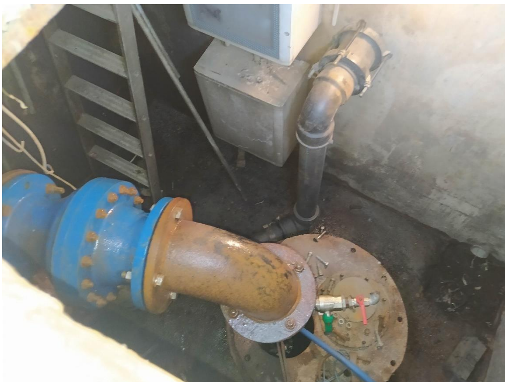
Figura 9 - pozzo Roddo 1 esistente – particolare testa pozzo
