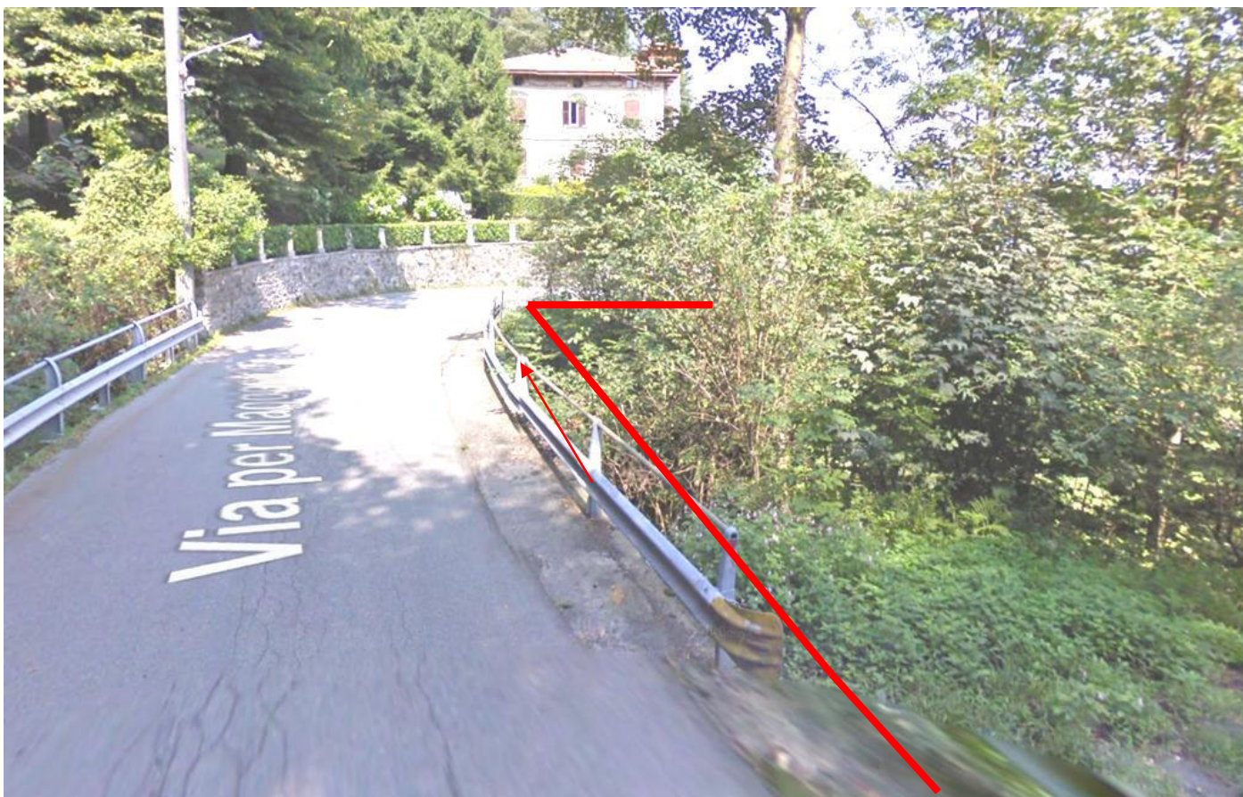
F2 - PONTE CANALE SUL RIO DELLA SACCA SUL LATO DI VALLE. L'OPERA E' IN AREA DI VINCOLO PAESAGGISTICO IN RELAZIONE ANCHE ALLA FASCIA DI 150 M DALLE SPONDE DEL RIO. A MONTE E VALLE DEL PONTE IL COLLETTORE FOGNARIO SARA' OVVIAMENTE COMPLETAMENTE INTERRATO SOTTO IL SEDIME STRADALE
