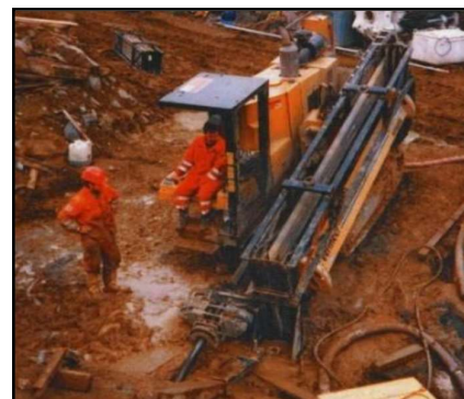
Figura 3 esempio di cantiere di TOC
