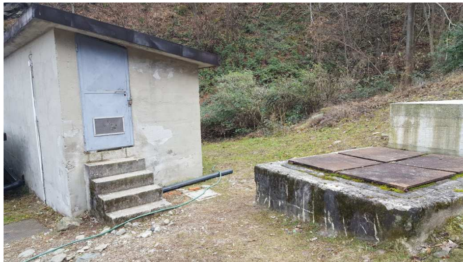
Corridoio di sedimentazione e pozzetto per deviazione flusso
