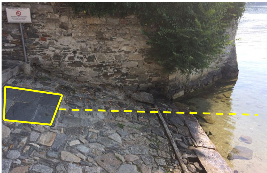
P.zza S. Giulio - Attuale trattamento con Fosse Imhoff e tubazione di scarico a lago esistente
