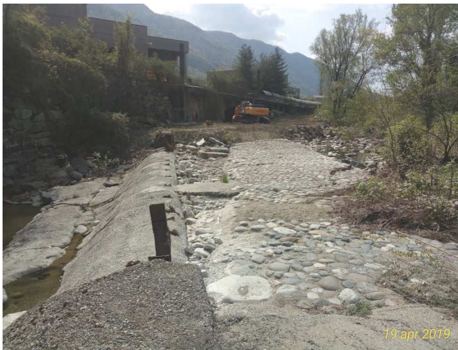
Fig. 5.1 – Briglia in corrispondenza della sponda destra del T. Strona, presso l'area di intervento.
