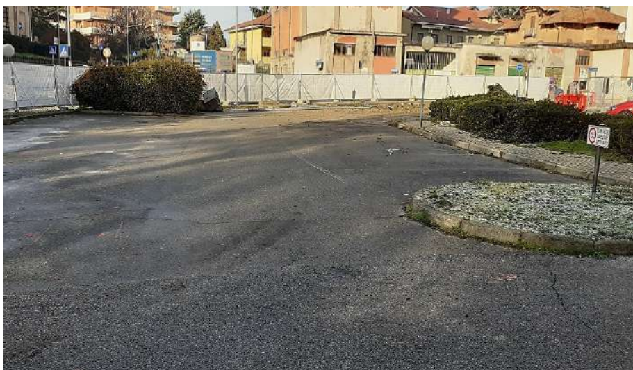
Lato sud del piazzale: sono evidenti le depressioni formatesi nelle pavimentazioni
