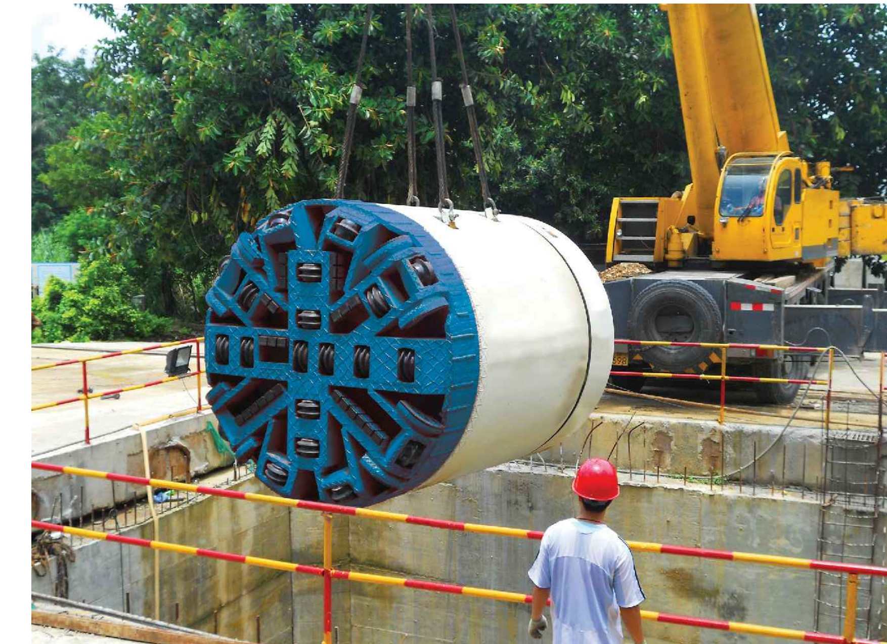
Figura 4 Calo testa fresante per scavo
