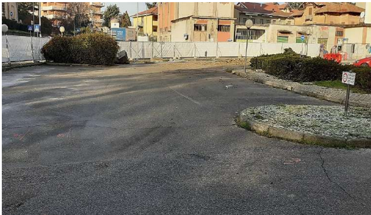
Lato sud del piazzale: sono evidenti le depressioni nella superficie della pavimentazione
