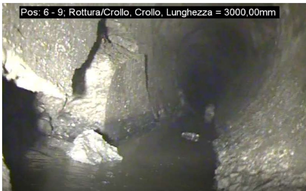
Immagine della video ispezione del collettore in corrispondenza della rottura localizzata
