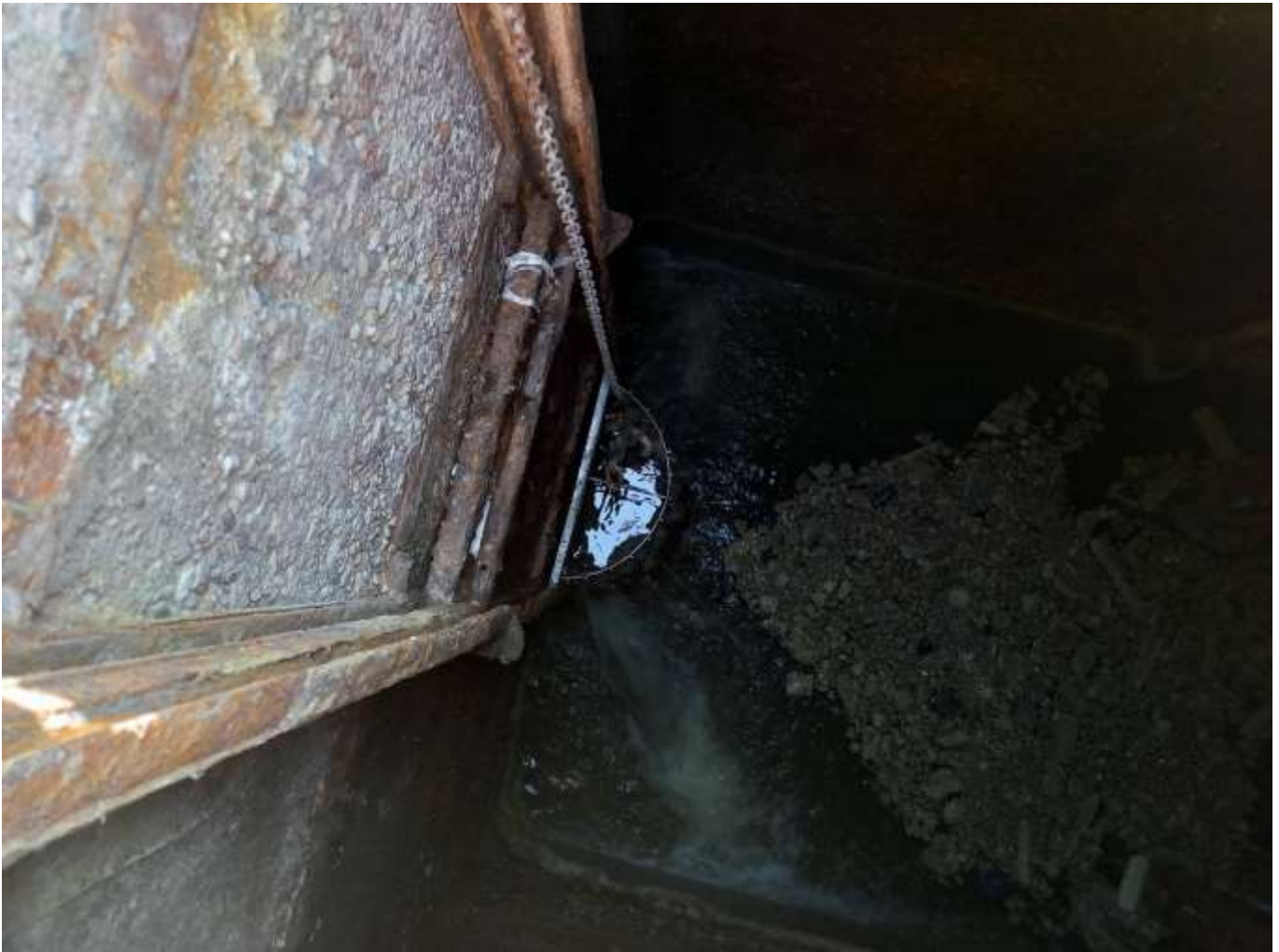
Figura 8 - manufatto esistente (interno stazione di sollevamento - griglia)
