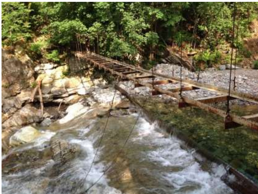
Figura 6 - passerella esistente investita dal deflusso di piena
