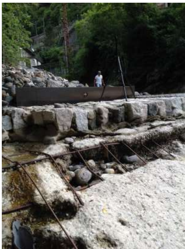
Figura 7 - danneggiamento al rivestimento lapideo della traversa
