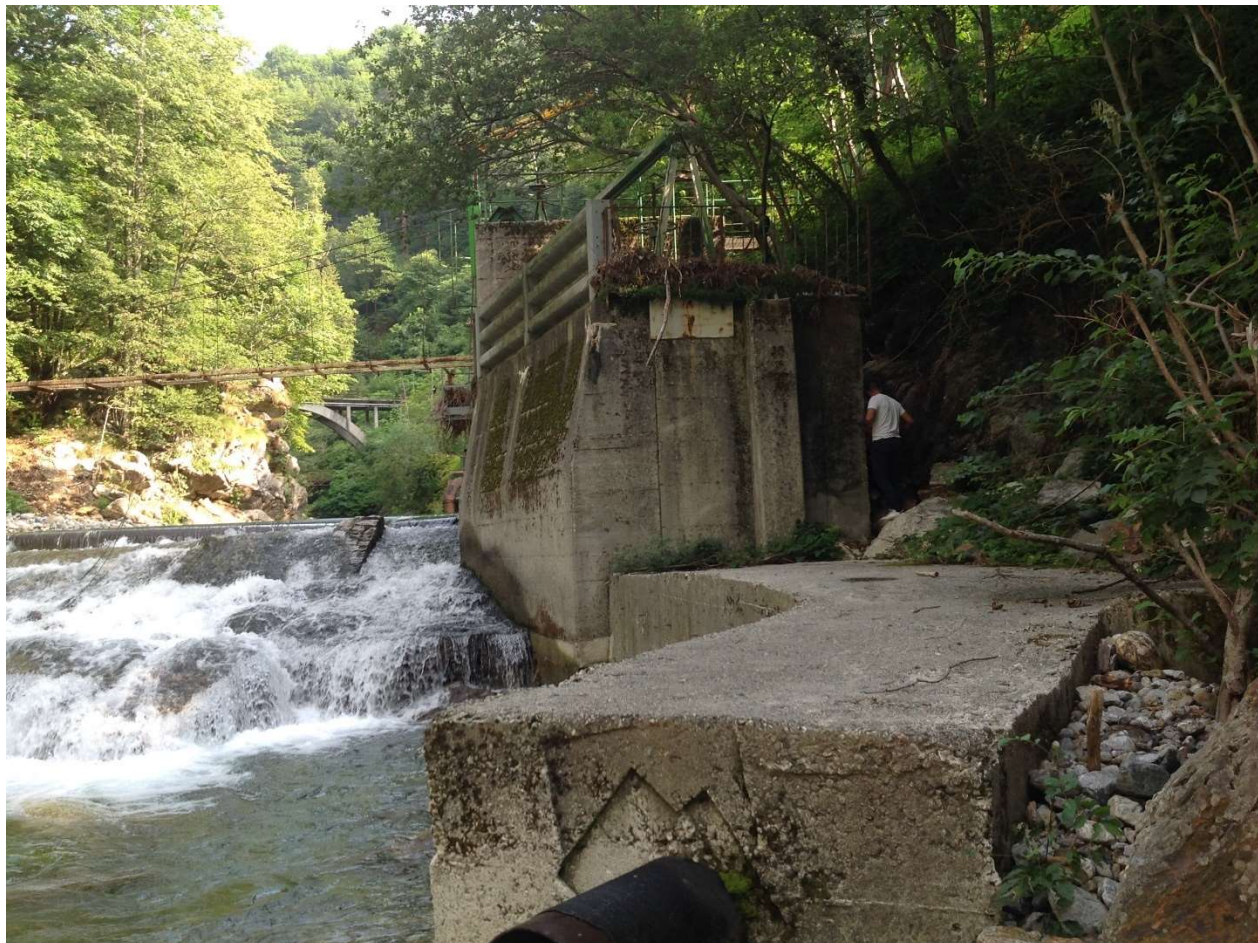
Figura 3 – vista da valle erosione in sinistra a tergo manufatto derivazione
