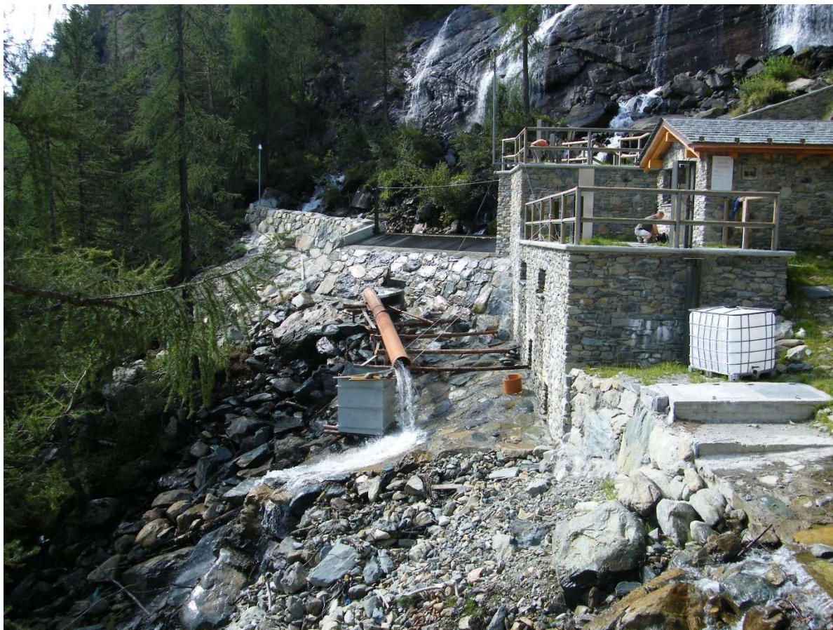
Figura 10 - sistema di collaudo iniziale rilascio DMV
