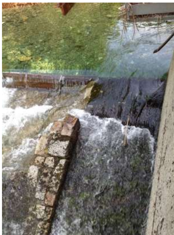
Figura 9 - intasamento griglia di derivazione
