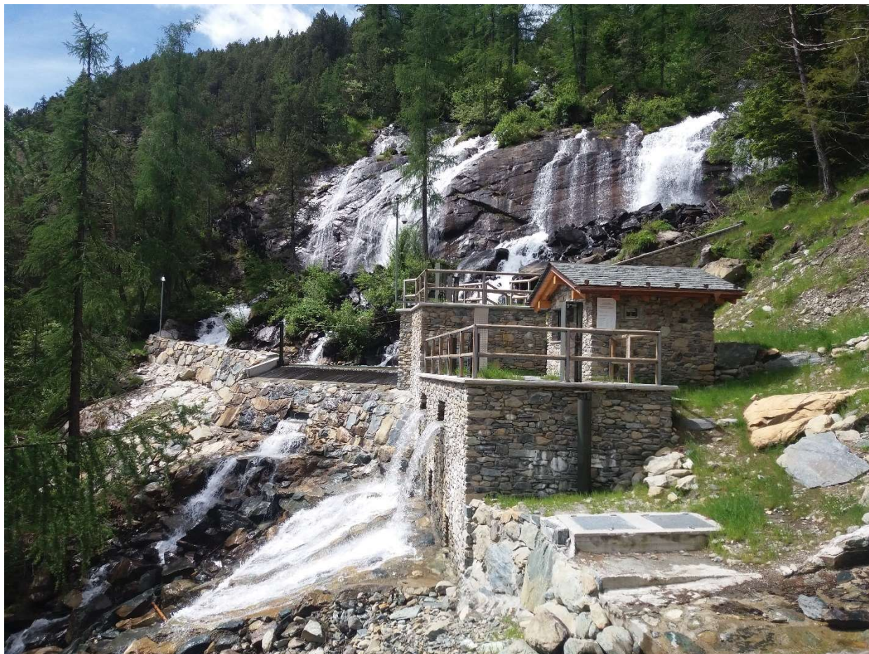
Figura 8 - vista di opera di presa con rilascio di DMV dalla soglia
