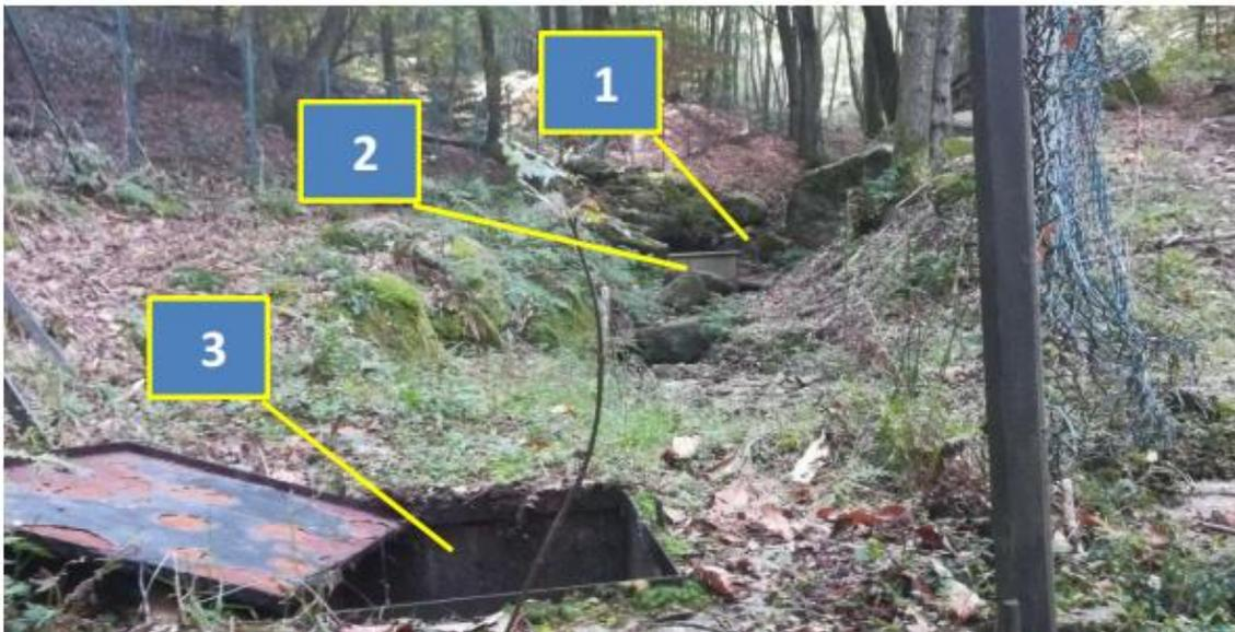
A differenza del Rio Moja, il **torrente Plesina** non è dotato di un'opera di presa. L'acqua viene attualmente captata mediante una tubazione mobile che viene posizionata di volta in volta in piccole pozze in gradi di invasare il tubo. A seguito di eventi di pioggia, anche di moderata entità, la portata del torrente sposta la tubazione che deve essere ogni volta riposizionata a mano dall'operatore.
