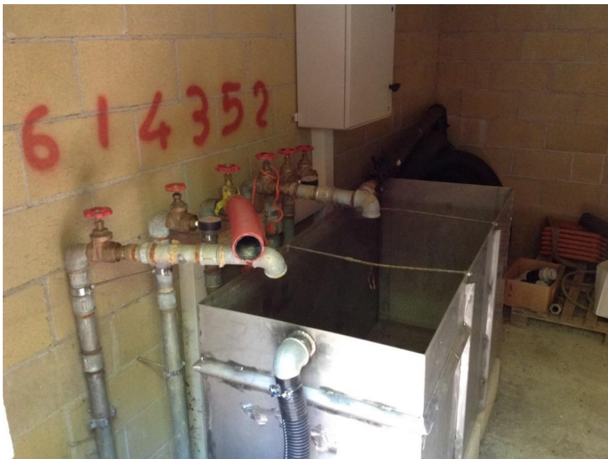
Figura 14 - vasca esistente con in primo piano la tubazione di troppo pieno da modificare
