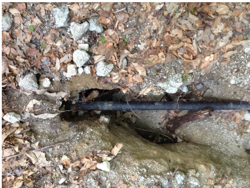
Figura 4 - erosione localizzata attorno alla tubazione di acquedotto esistente
