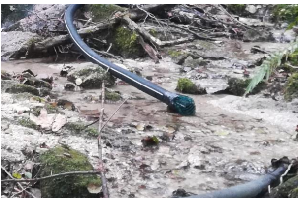
PARTICOLARE DELLA PARTE TERMINALE DELLA TUBAZIONE DI PRESA
