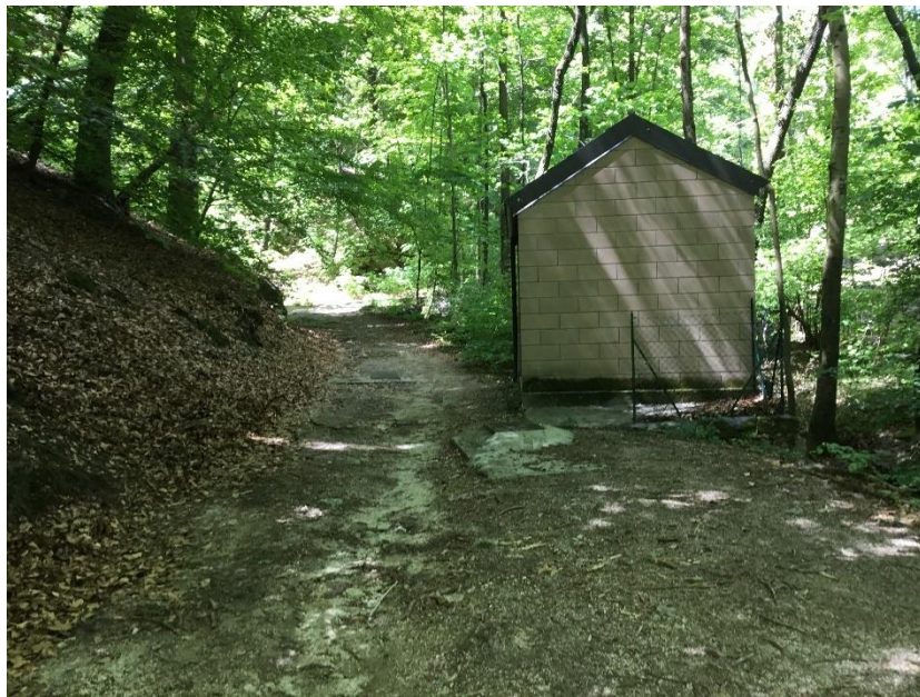
Figura 2 - tratto iniziale a fianco opere a servizio acquedotto con tracce di ruscellamento al centro della sede
