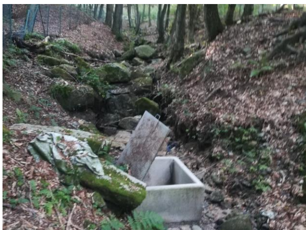
POZZETTO DI CAPTAZIONE [1] COPERTO CON LA PIDDA
