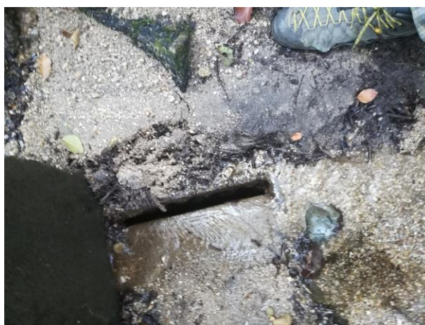
POZZETTO DI CAPTAZIONE [1] CON LA PIDDA RIMOSSA
