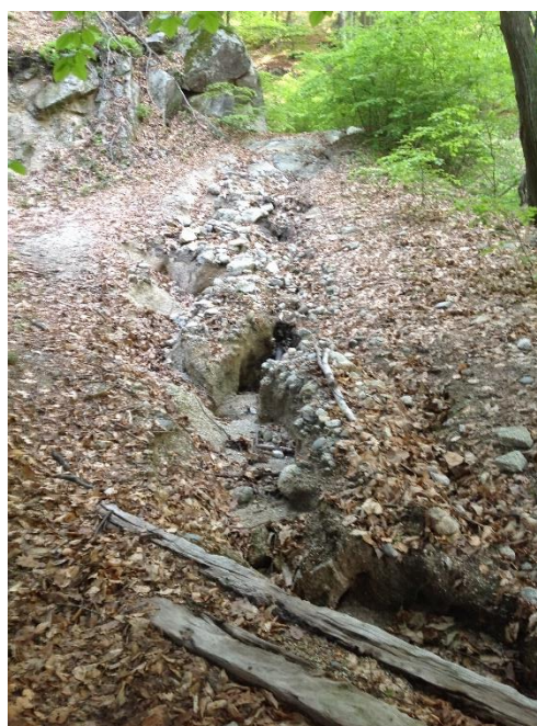
Figura 3 - erosione a monte canalina esistente in legname intasata con materiale vegetale
