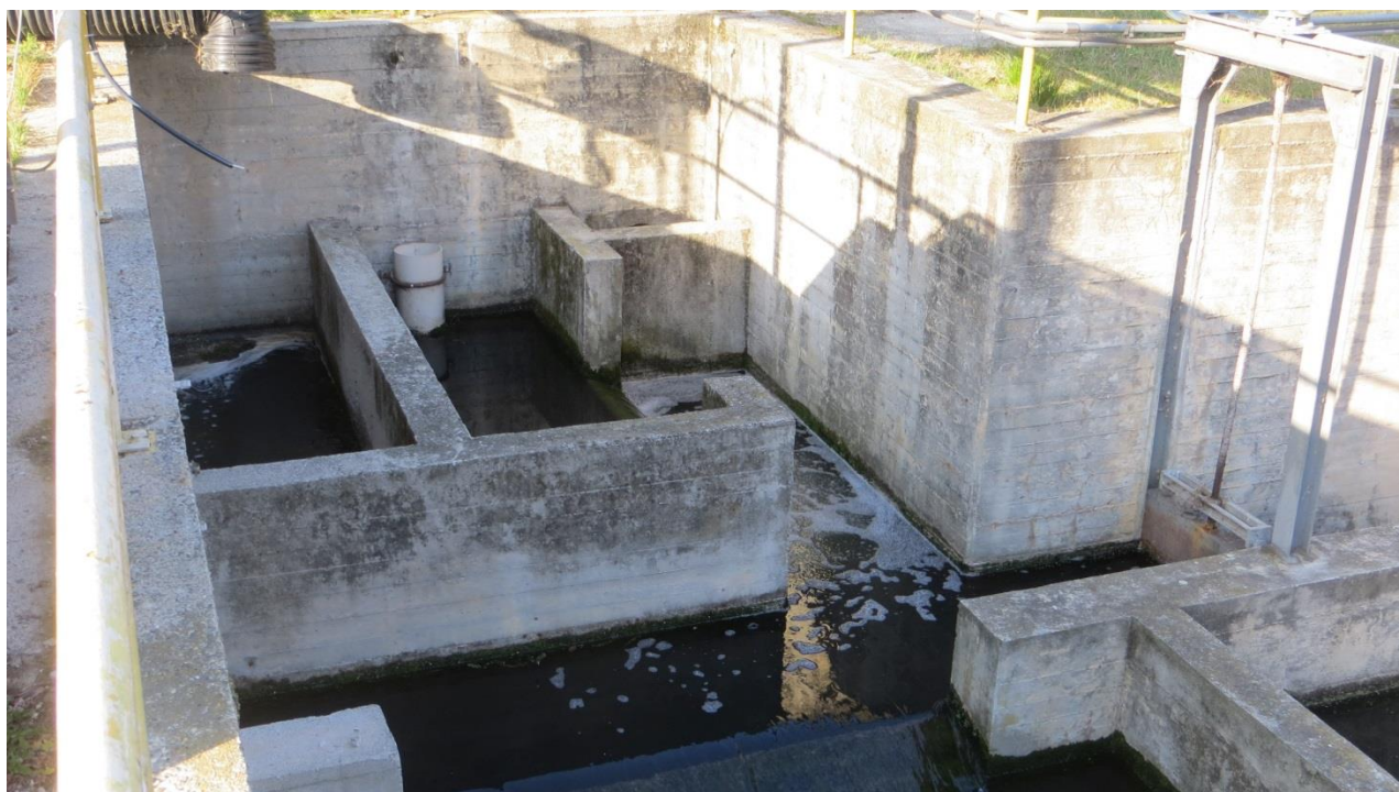
Impianto esistente: circuito iniziale clorazione
