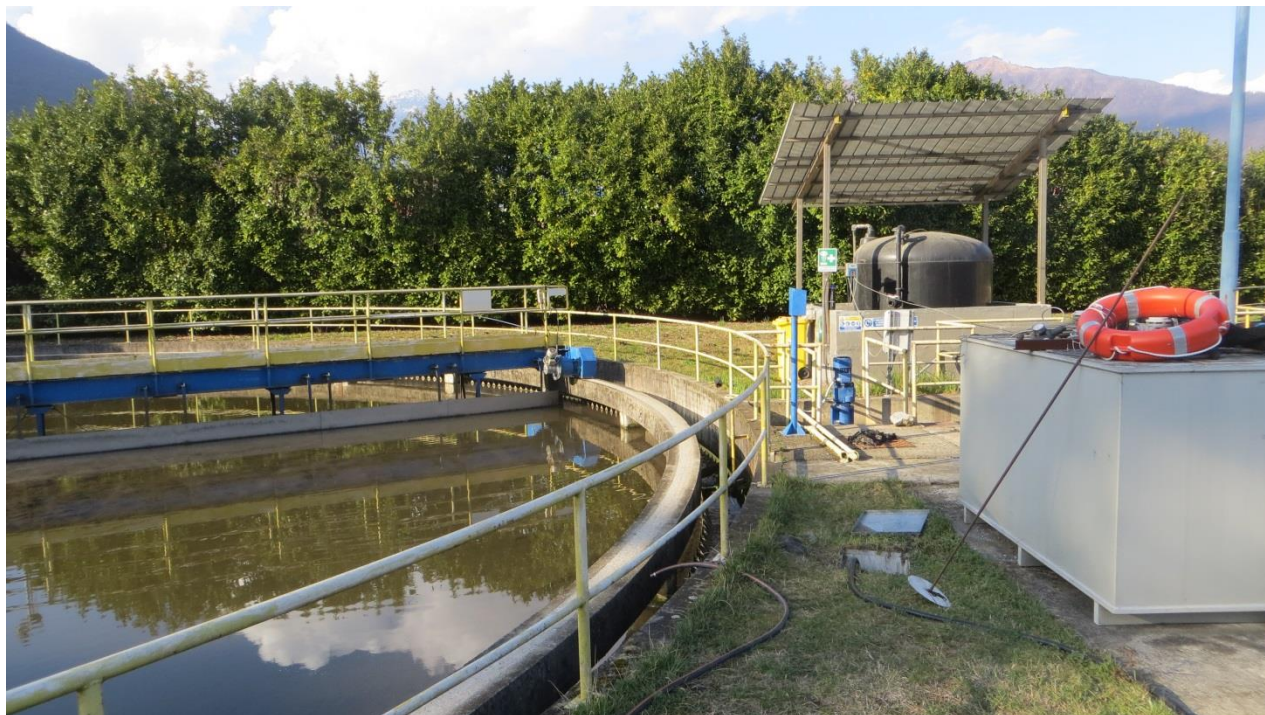
Impianto esistente: sedimentatore secondario esistente
