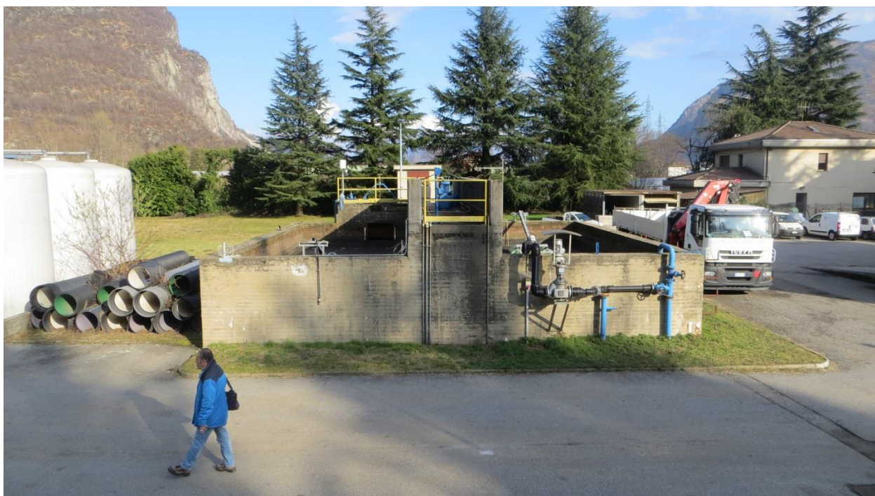
Impianto esistente: vasca di stabilizzazione fanghi esistente da mantenere).
