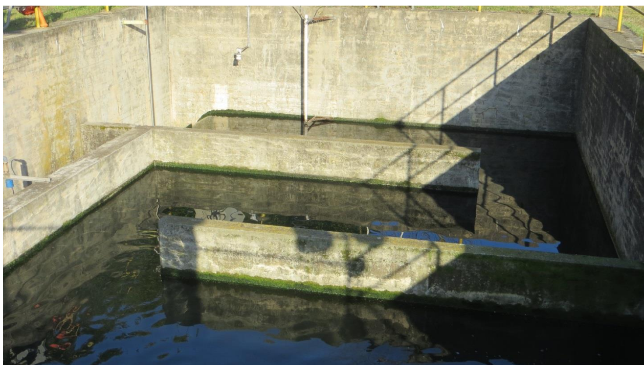
Impianto esistente: setti interni alla clorazione
