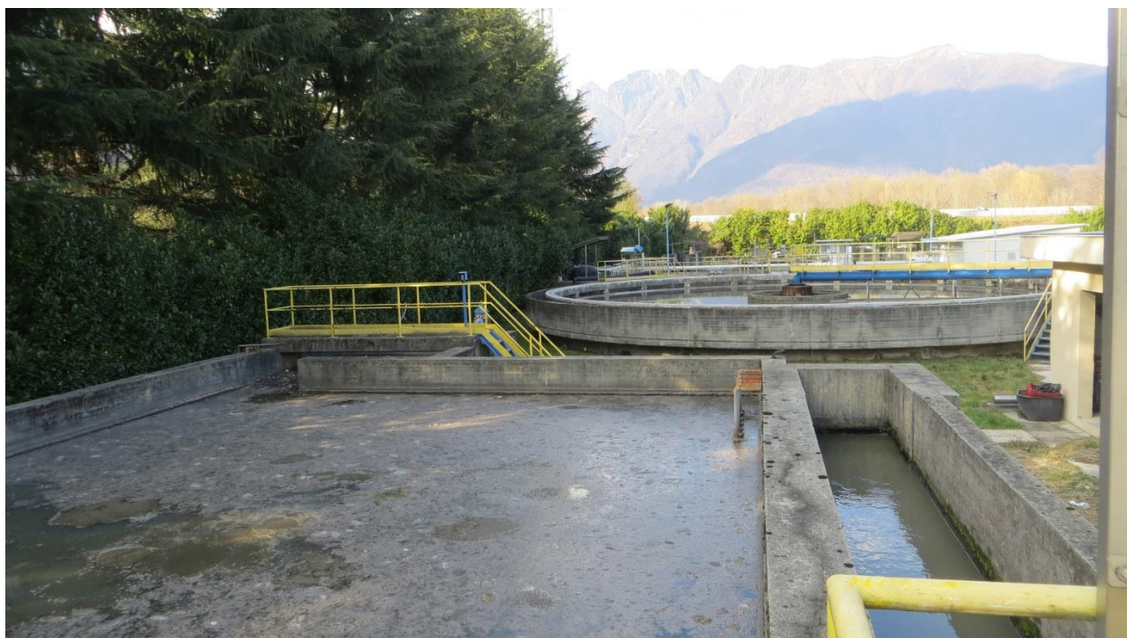
Impianto esistente: zona vasca equalizzazione esistente (non utilizzata) e sedimentatore primario
