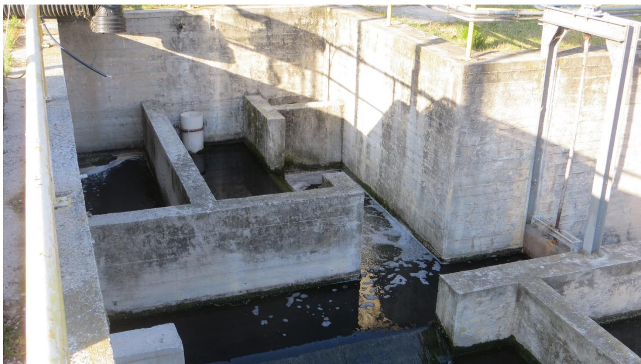
Impianto esistente: circuito iniziale clorazione
