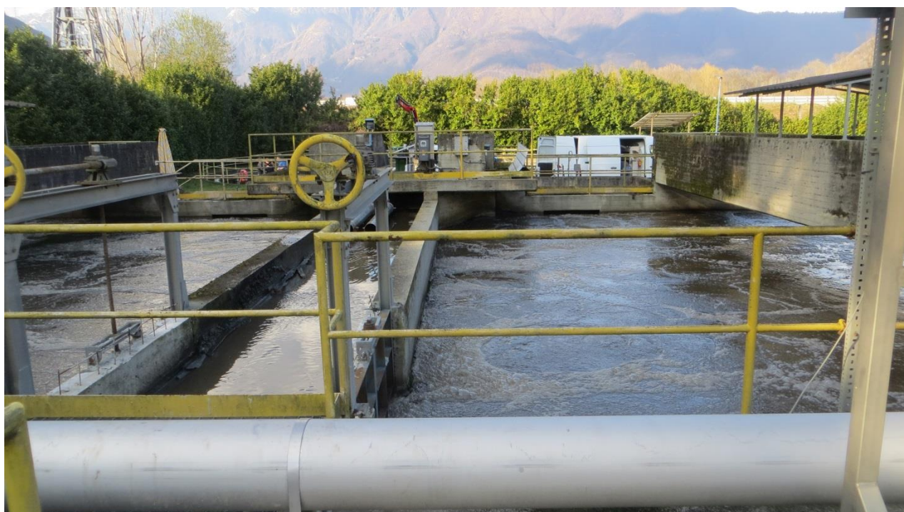
Impianto esistente: reattori biologici eserciti con aerazione intermittente
