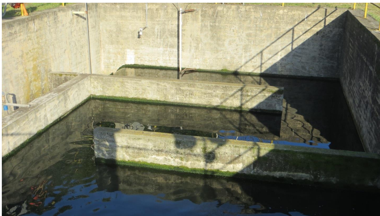
Impianto esistente: setti interni alla clorazione
