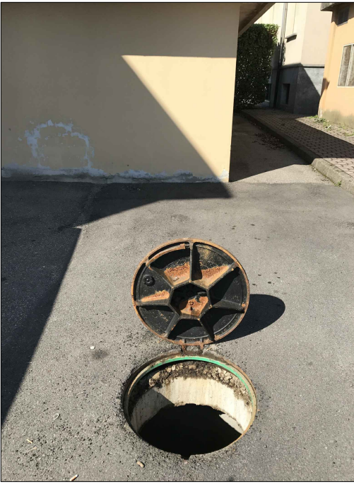
VISTA n.3 - Pozzetto esistente con saracinesca
