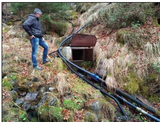
Figura 4 – Bottini di monte (a sx) e valle (a dx) delle sorgenti del Mour
