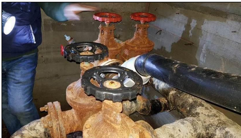
Figura 6 – Pozzetto di ispezione posto nei pressi della vasca di riunione dal quale si dirama la condotta di alimentazione della frazione Orcesco
