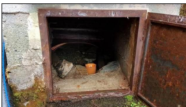
Figura 5 – Il bottino di valle presenta chiari problemi di funzionalità: bassa sommergenza della presa (a sx), che determina l'ingresso d'aria in condotta, scarse caratteristiche strutturali e dimensionali e condotta di adduzione delle portate emunte alla vasca di riunione posata fuori terra (a dx)
