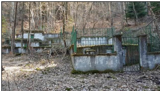
Figura 7 – Bottini di presa siti in località “Cresta” (a sx) e ripresa fotografica interna di uno di loro (a dx)
