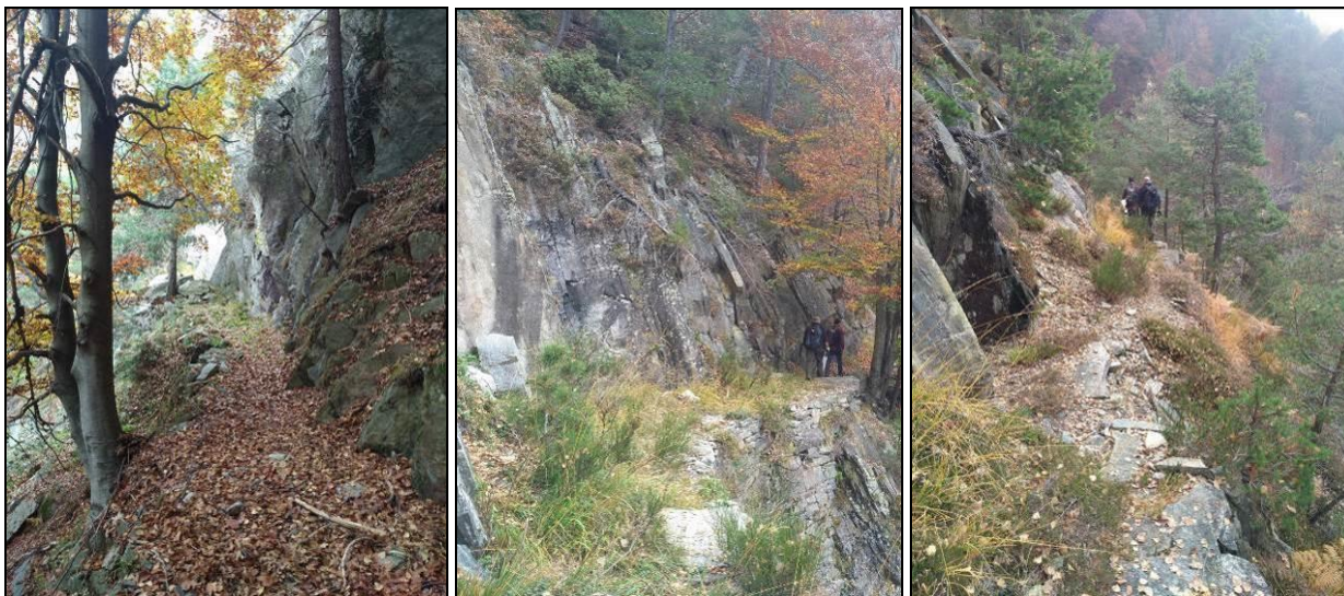
Figura 4 - Ripresa fotografica del tracciato della condotta di adduzione: sono evidenti le condizioni di dissesto del versante che potrebbero determinare un improvviso danneggiamento della condotta
