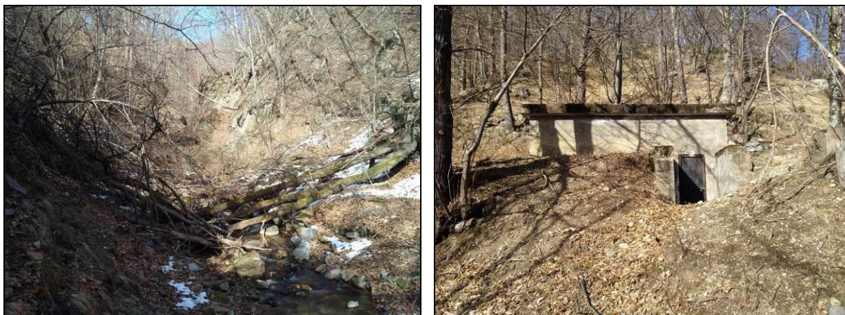
Figura 19 – Ripresa fotografica dell’impluvio ove è collocato il bottino di presa di Ca’ Turbin e della vasca di carico ove sono convogliate le portate captate e da qui distribuite
