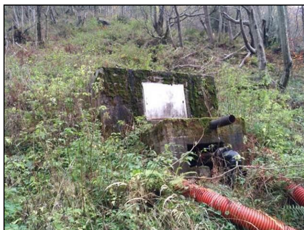
Figura 12 – Riprese fotografiche di due dei bottini di presa delle sorgenti dell'Antoliva
