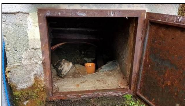
Figura 5 – Il bottino di valle presenta chiari problemi di funzionalità: bassa sommersenza della presa (a sx), che determina l'ingresso d'aria in condotta, scarse caratteristiche strutturali e dimensionali e condotta di adduzione delle portate emunte alla vasca di riunione posata fuori terra (a dx)
