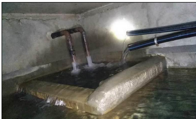
Figura 8 – Interno della vasca di riunione del Mour: a sinistra (parete est della vasca) sono visibili le condotte provenienti dai bottini di loc. "Cresta", a destra quelle dei bottini del "Mour" (parete ovest della vasca)
