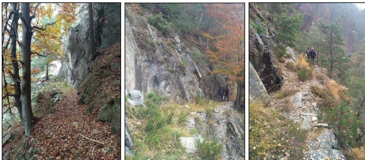
Figura 17 – Ripresa fotografica del tracciato della condotta di adduzione: sono evidenti le condizioni di dissesto del versante che potrebbero determinare un improvviso danneggiamento della condotta
