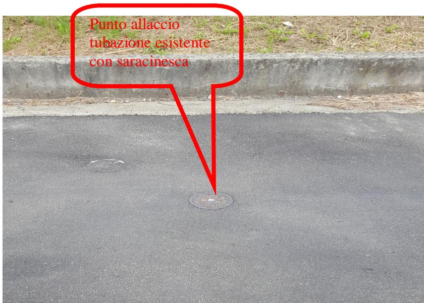
Foto 2: saracinesca esistente punto di inizio sostituzione tubazione
