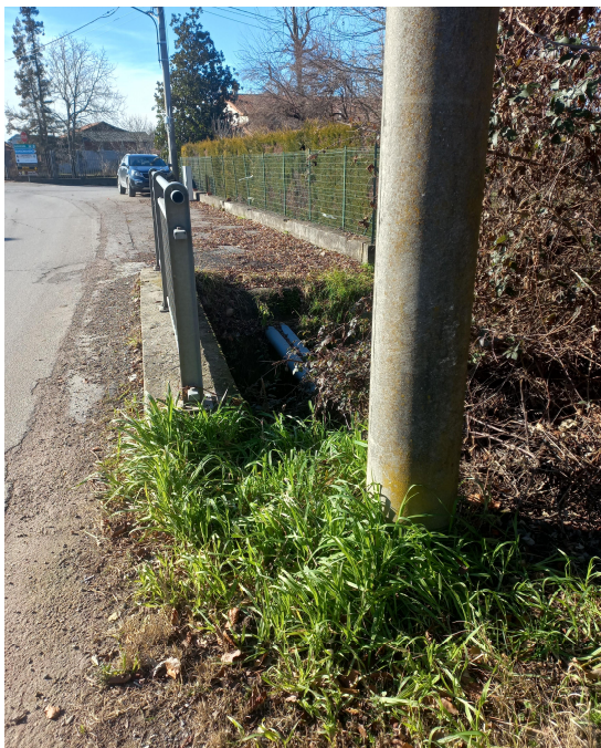
Foto 13: posizione palo luce Enel Illuminazione pubblica da far temporaneamente rimuovere per la realizzazione del passaggio sotto alveo Roggia Molinara.
