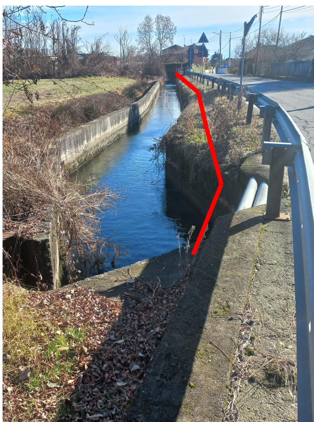
Foto 8: Tratto tubazione in pressione staffato su ponte roggia Molinara e poi interrato fino al passaggio sul ponte Lirone
