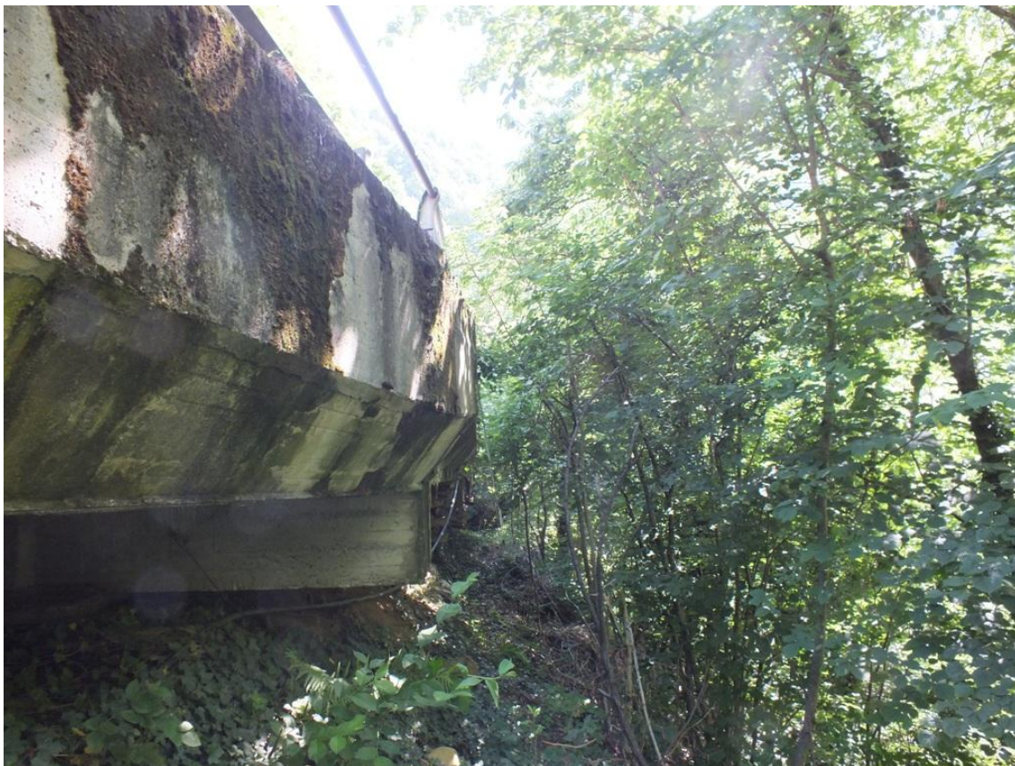
Figura 3 - Vista laterale del banchettone dove andrà ancorata la nuova condotta
