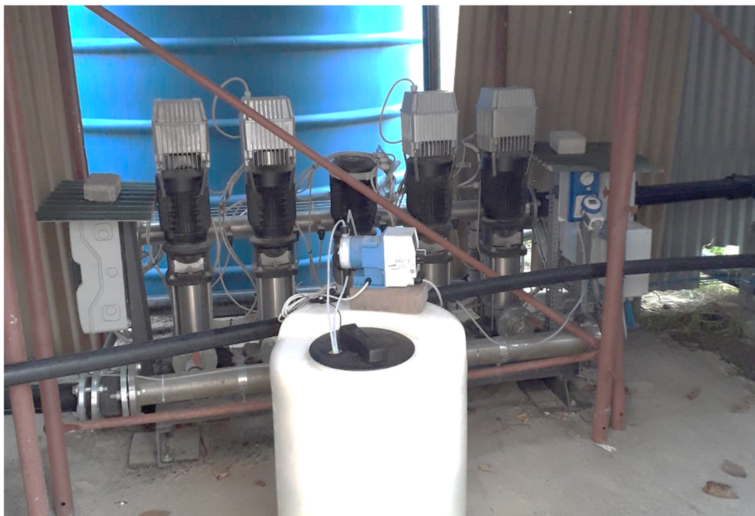
Figura 3 Gruppo pompe esistenti per rilancio alle frazioni
