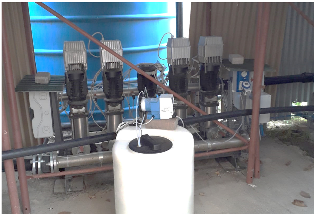
Figura 3 Gruppo pompe esistenti per rilancio alle frazioni
