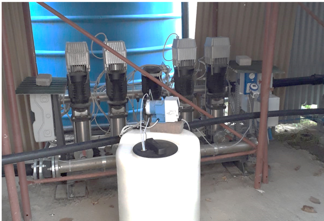
Figura 3 Gruppo pompe esistenti per rilancio alle frazioni
