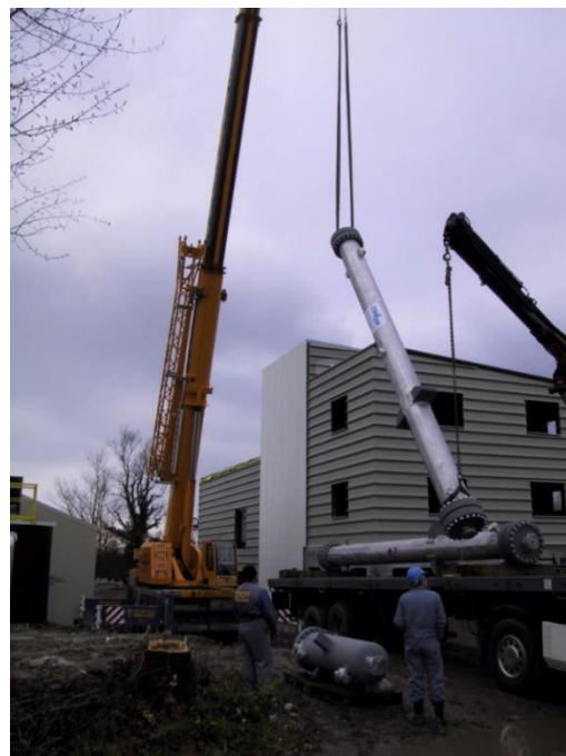
Figura 6 Sistemi di sollevamento delle apparecchiature elettromeccaniche
