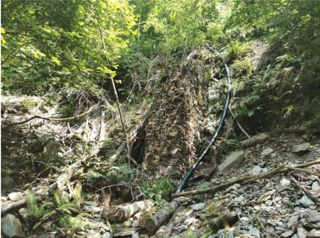
**Foto n°3 – TUBAZIONE PROVVISORIA IN ALVEO RIO VALLE DEL FERRO**
