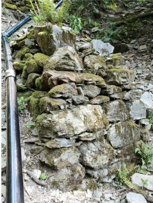
**Foto n°5 – TUBAZIONE PROVVISORIA POSATA LUNGO IL VERSANTE**
