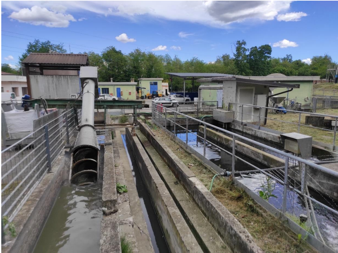
Figura 2: Unità di grigliatura fine in canale
