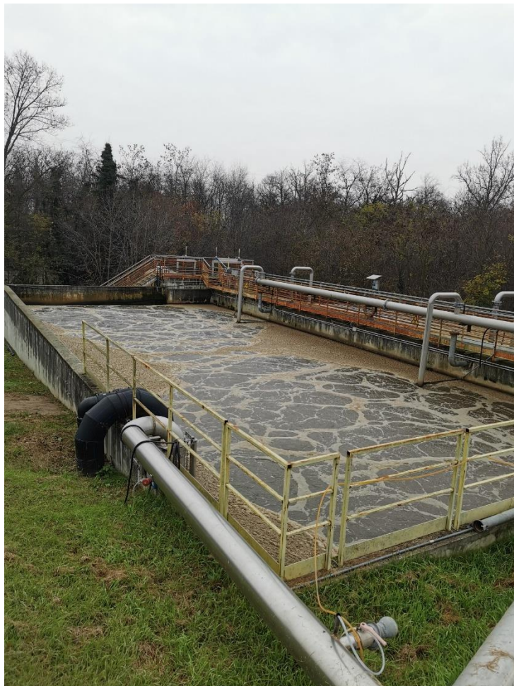
Figura 6: Vasca di ossidazione/nitrificazione
