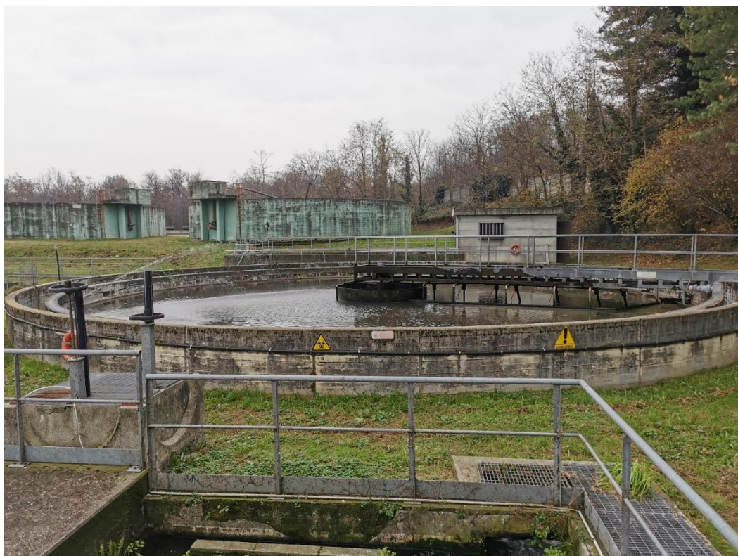
Figura 8: Sedimentatore secondario D=19m
