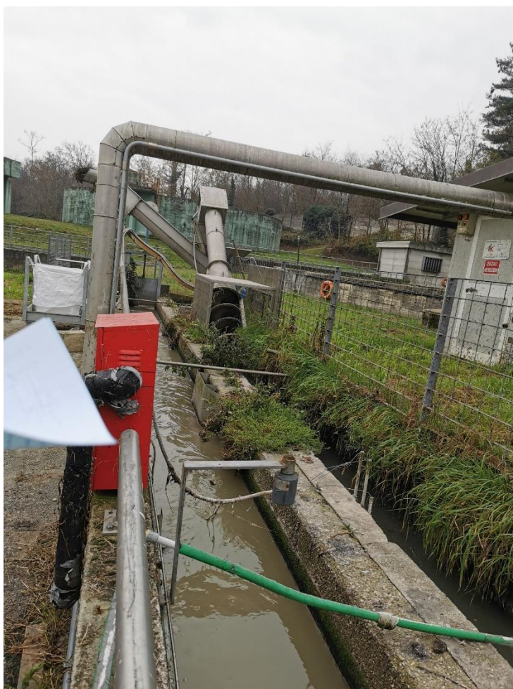
Figura 4: Canale principale e sullo sfondo canale di bypass dotato di grigliatura fine
