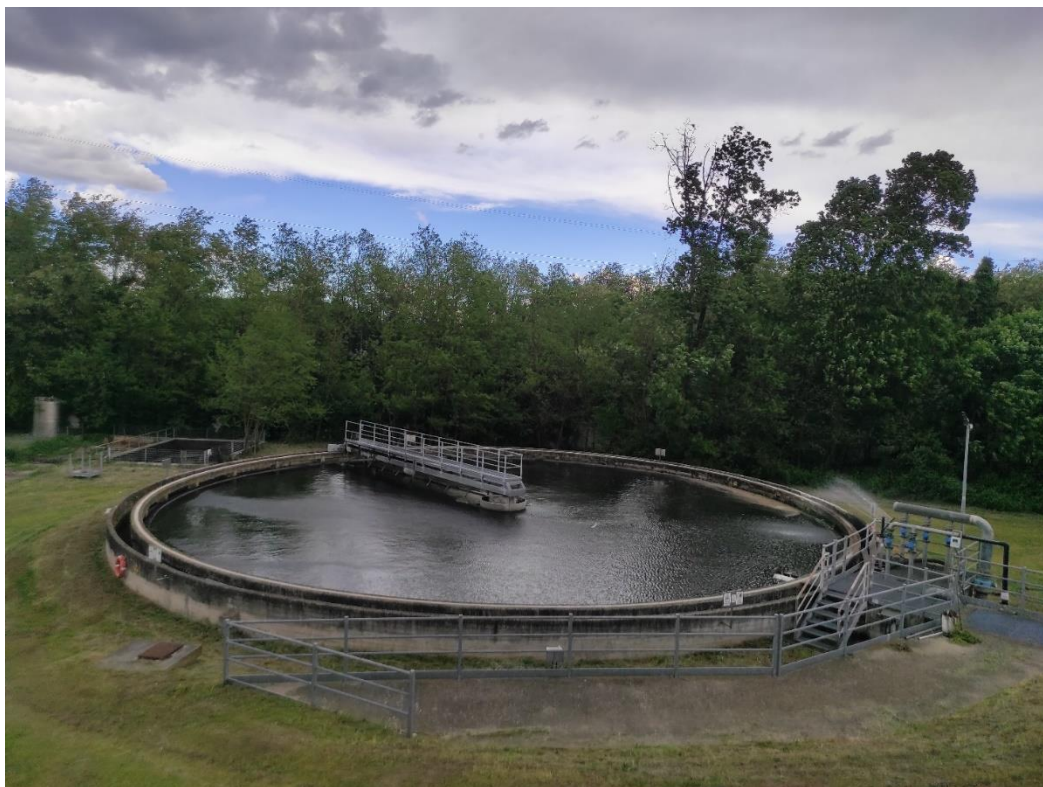
Figura 7: Sedimentatore secondario D=26m
