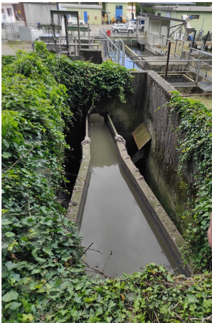
Figura 1: Canale di ingresso del refluo
