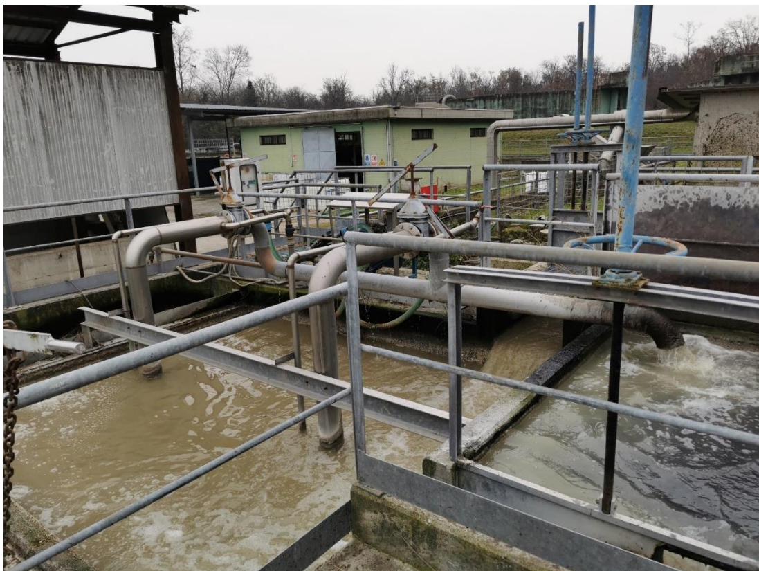
Figura 3: Comparto di dissabbiatura/disoleatura
