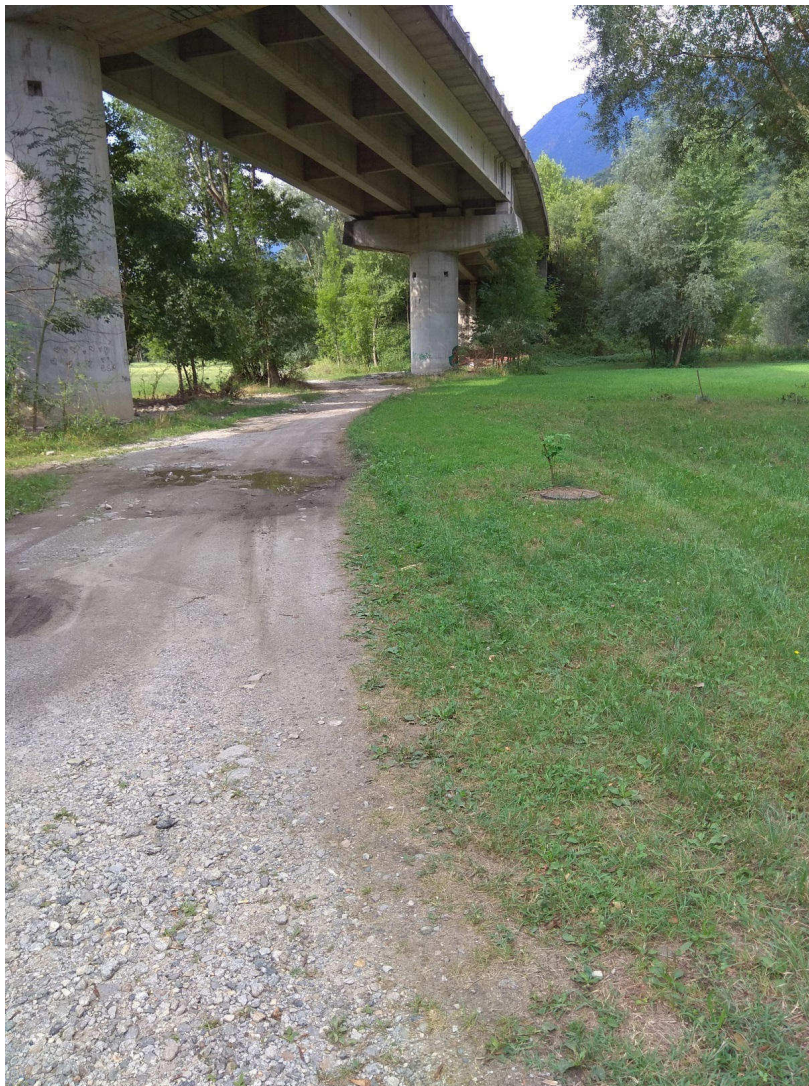
Figura 3 Uno dei tratti in cui la tubazione verrà interrata lungo strade interpoderali.
