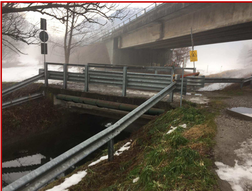
Opere previste (inserimento condotta su ponte)
