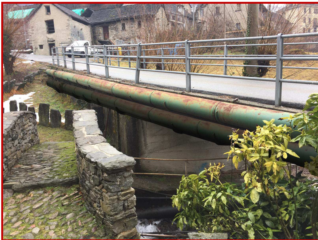
Opere previste (inserimento condotta su ponte)
