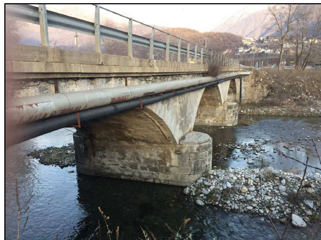
LATO SUD TUBAZIONE FOGNATURA ESISTENTE
