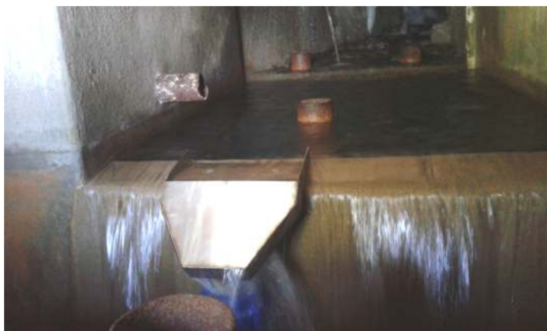
Interno del bottino di presa della sorgente "Fungio". Nella foto in basso si nota lo "scivolo" applicato per facilitare la misura della portata liquida mediante Bazin.
