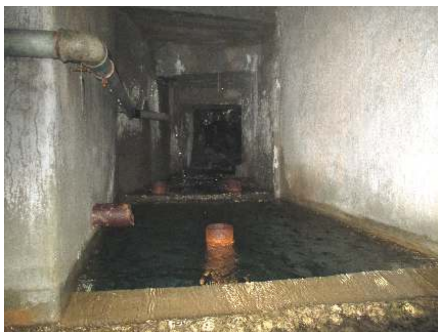
Interno del bottino di presa della sorgente "Fungio". Nella foto in basso si nota lo "scivolo" applicato per facilitare la misura della portata liquida mediante Bazin.
