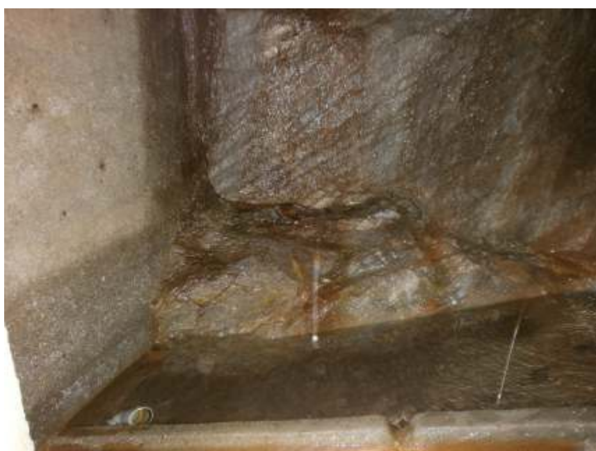
Interno del bottino di presa della sorgente "Muretto Bassa", che mostra l'emergenza delle portate liquide dall'ammasso roccioso fratturato.
