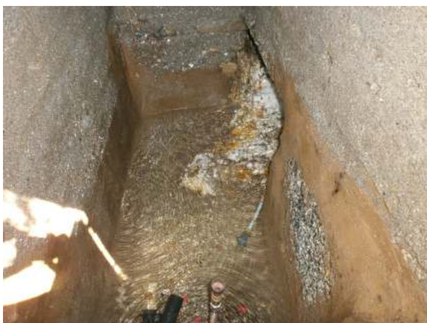
Interno del bottino di presa della sorgente "Fontana Quadra", che mostra l'emergenza delle portate liquide dall'ammasso roccioso fratturato.
