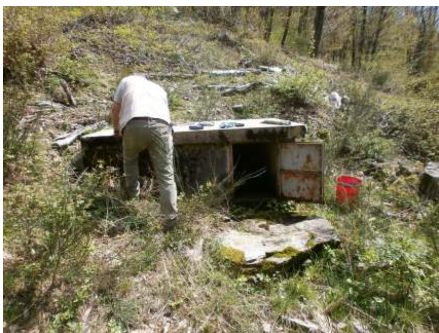
Vista del manufatto in c.a., dotato di sportello metallico, al quale vengono convogliate le acque captate dai due pozzetti della sorgente "Muretto Alta" e da cui parte la condotta collegata all'Acquedotto Comunale. In corrispondenza di questo manufatto sono state effettuate le misure di portata.
