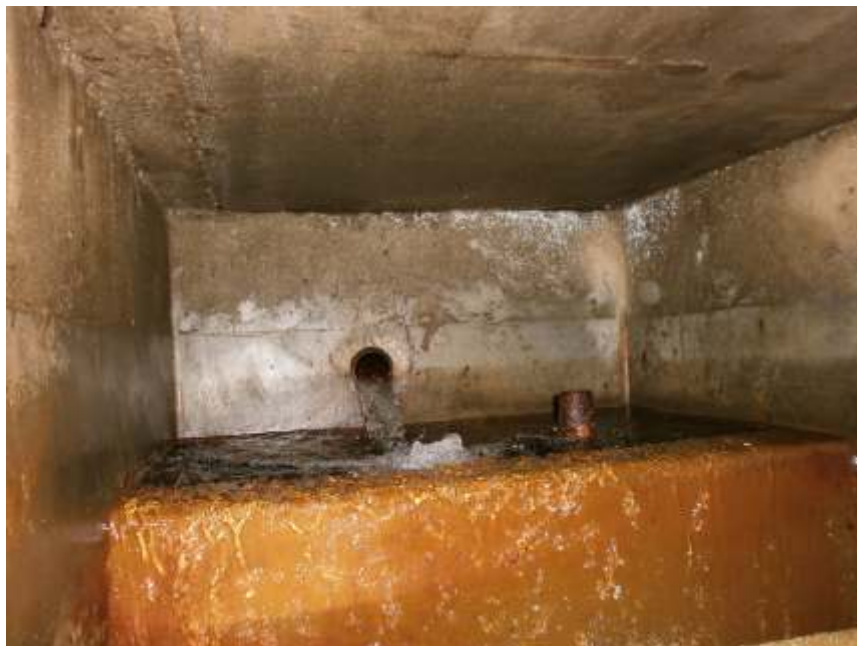
Sorgente "Muretto Alta". Vista dell'interno del manufatto in c.a., con le vasche di sedimentazione e di carico.
