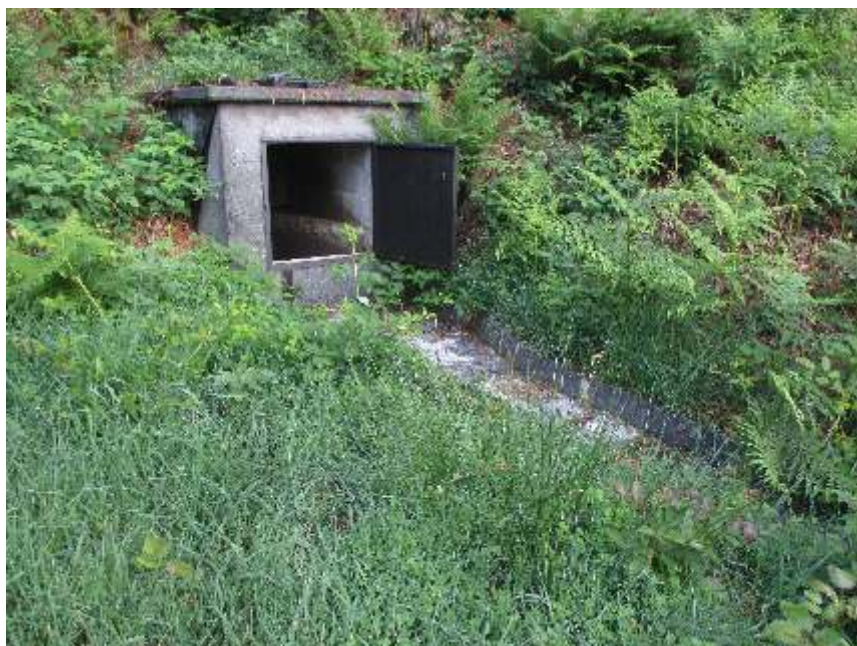
Bottino della sorgente "Fontana Quadra". Si nota la lastricatura della pavimentazione per un agevole allontanamento delle acque meteoriche.
