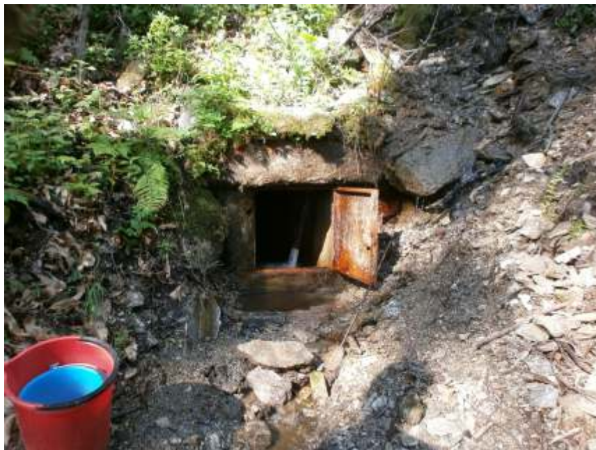
Bottino collettore a 525 m s.l.m. In esso affluiscono anche le portate dei due bottini superiori. Qui sono state fatte le misure di portata.
