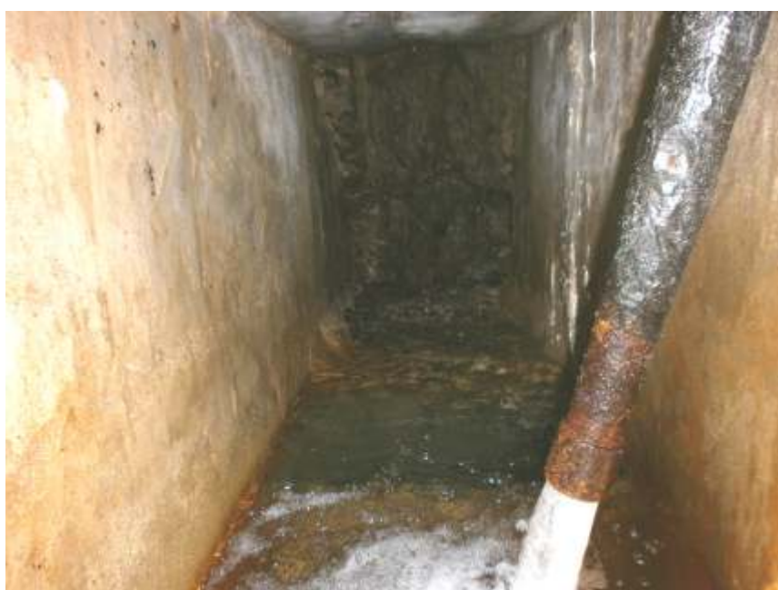
Interno del bottino collettore. In primo piano si vede il tubo che fa affluire le portate dai due bottini superiori.
